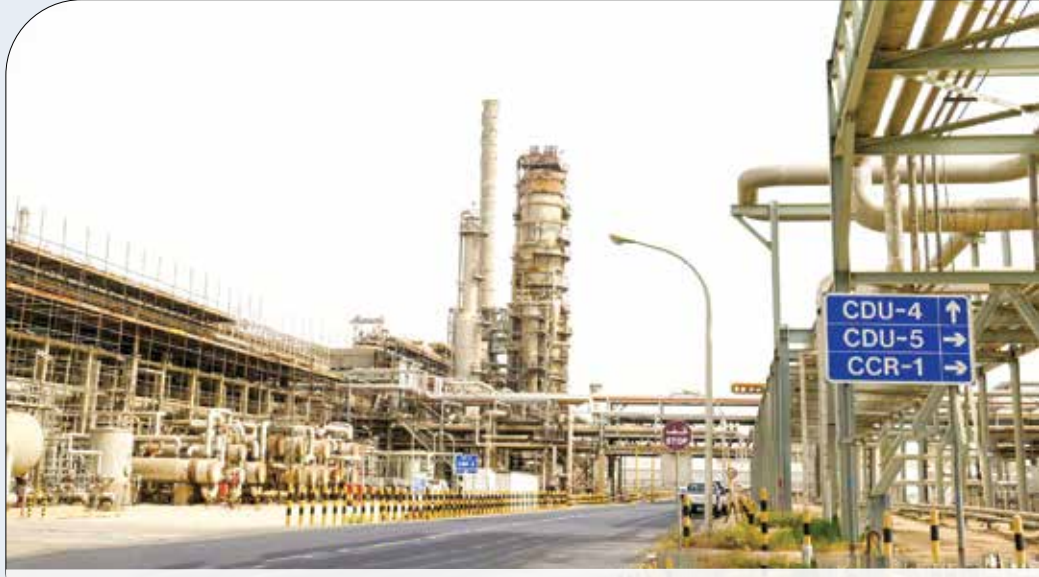
● يوجد بمصفاة ميناء الأحمدى عدة وحدات لتقطير النفط الخام
