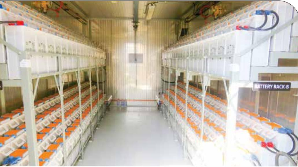
● بطاريات تستخدم في أنظمة الطاقة لضمان استمرارية التشغيل في حال انقطاع الكهرباء
