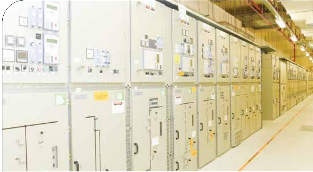
• قواطع كهربائية داخل محطة فرعية تستخدم للتشغيل والتحكم بالمعدات الكهربائية
