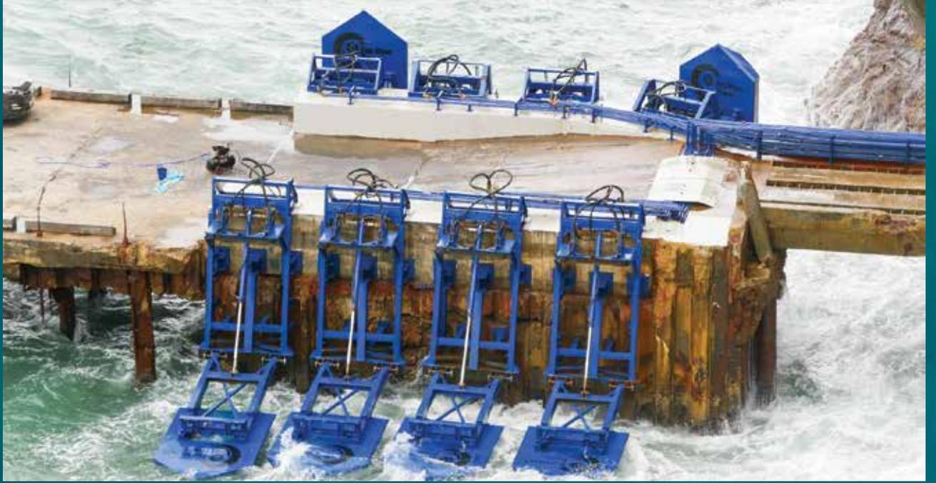
■ محولات الطاقة الموجية تستخدم حركة المياه لتوليد الكهرباء
