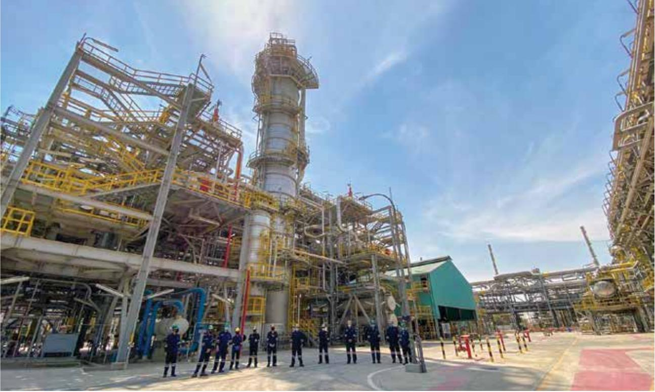
■ وحدة معالجة المياه الحمضية تستهدف فصل المركبات الهيدروكربونية والأمونيا وغاز كبريتيد الهيدروجين المصاحب للمياه
