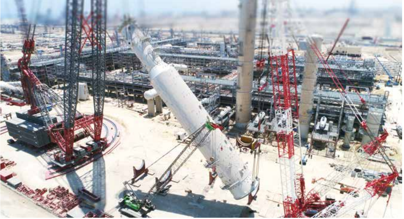
■ جانب من أعمال مشروع وحدة إسالة الغاز
