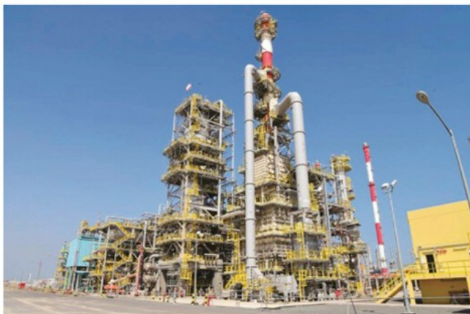
مشروع الوقود البيئي
