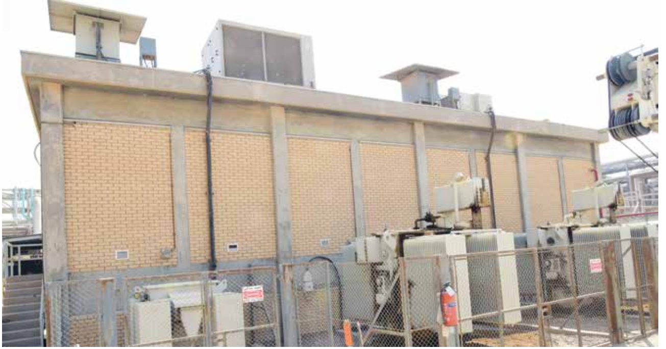
■ استبدال محطات الكهرباء القديمة بمصفاة ميناء الأحمدى بأخرى جديدة تتمتع بتقنيات متطورة
