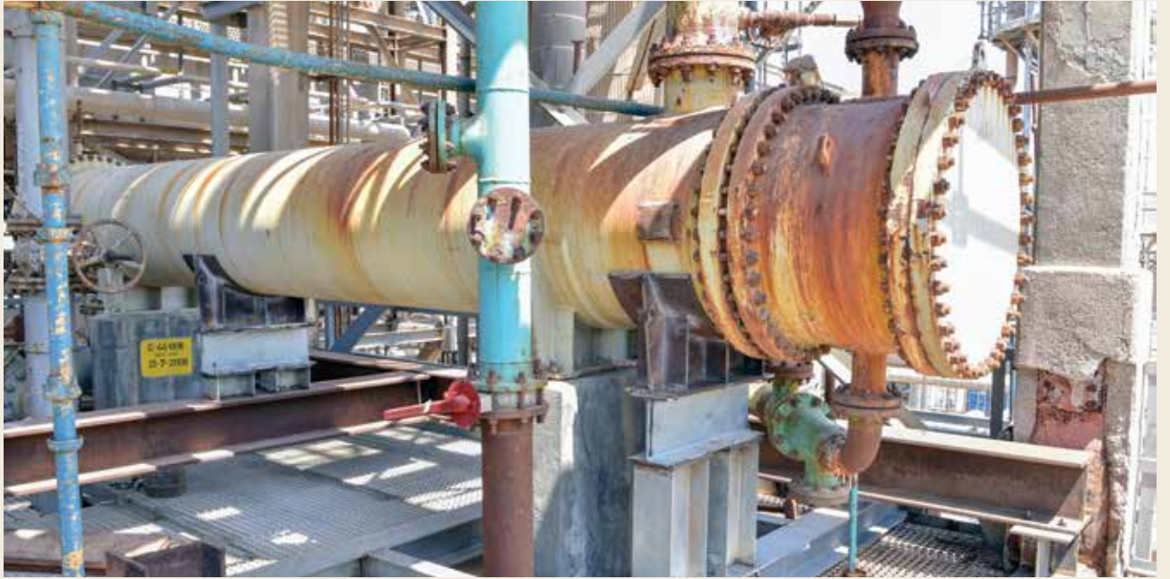
■ تركيب دعامة إضافية تحت العوارض المتآكلة لتجنب حدوث أي مخاطر
